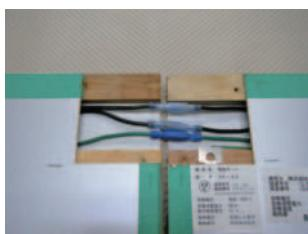
①電源ケーブルおよび渡り配線、パネル間の接続は電源線コネクターとアース線コネクターで行います。コネクターは抜けないように奥まで十分に差し込んでください。
