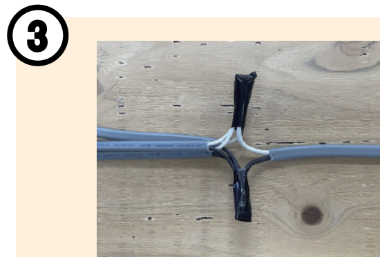
圧着結線した部分を絶縁テープで絶縁防湿処理をします。
